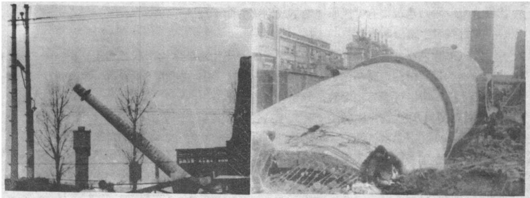
图10 烟囱爆破塌落过程
